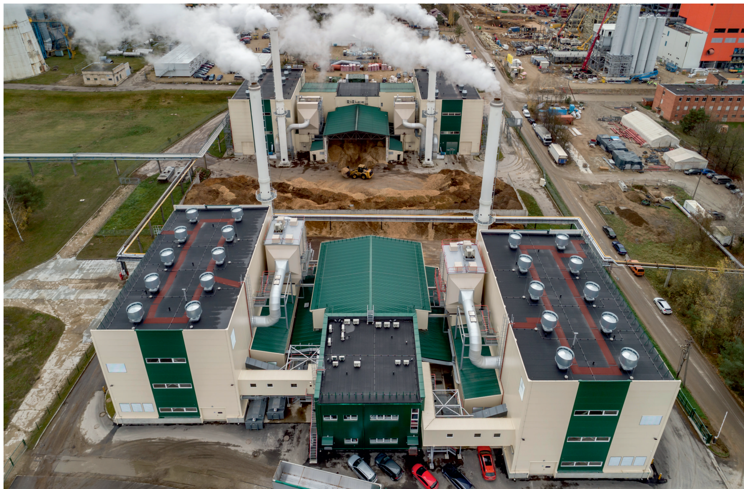
Kotłownia na biomasę o mocy 48 MW na Litwie.
