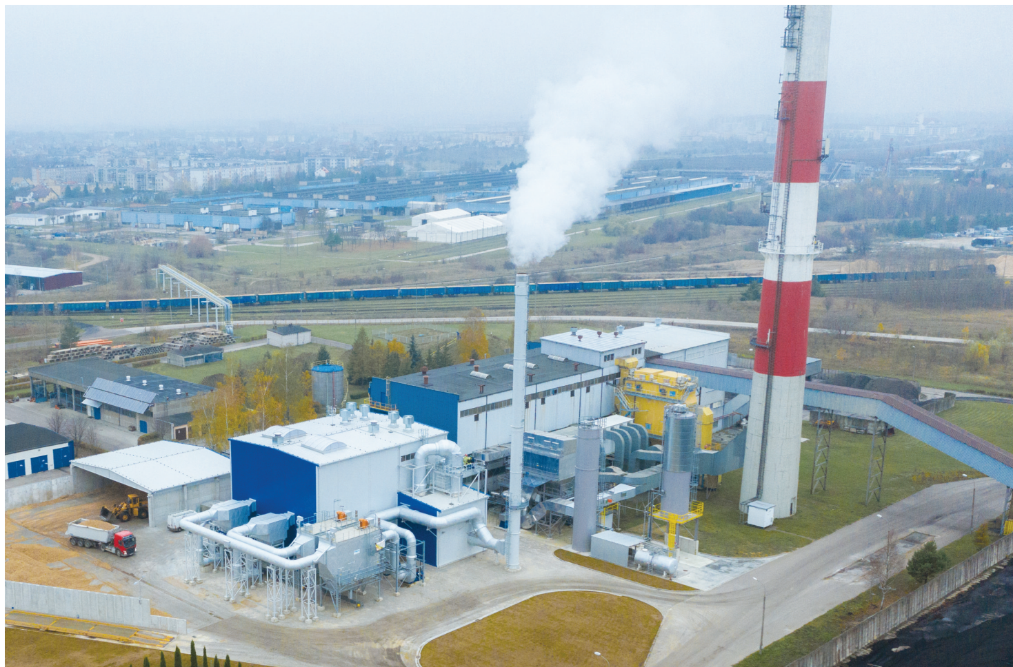
Kotłownia na biomasę o mocy 30 MW na Polska.
